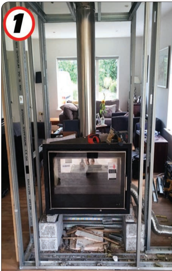
- INSTALLING INSERT STOVE USING METAL STUD FRAME
